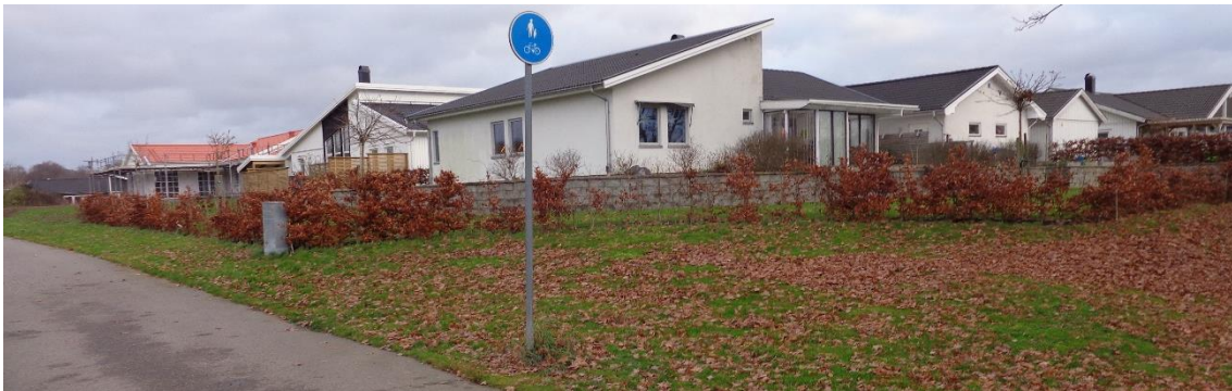
Figur 6: Bild från platsbesök 2018-12-03. Första radens hus i kvarteret Rosmarinen som är till största delen uppfört, enstaka tomter är under byggnation. Väg 13 ligger till vänster om gångbanan som syns i bild. Det finns också en bullerskyddsvall mellan gångbanan och väg 13.
