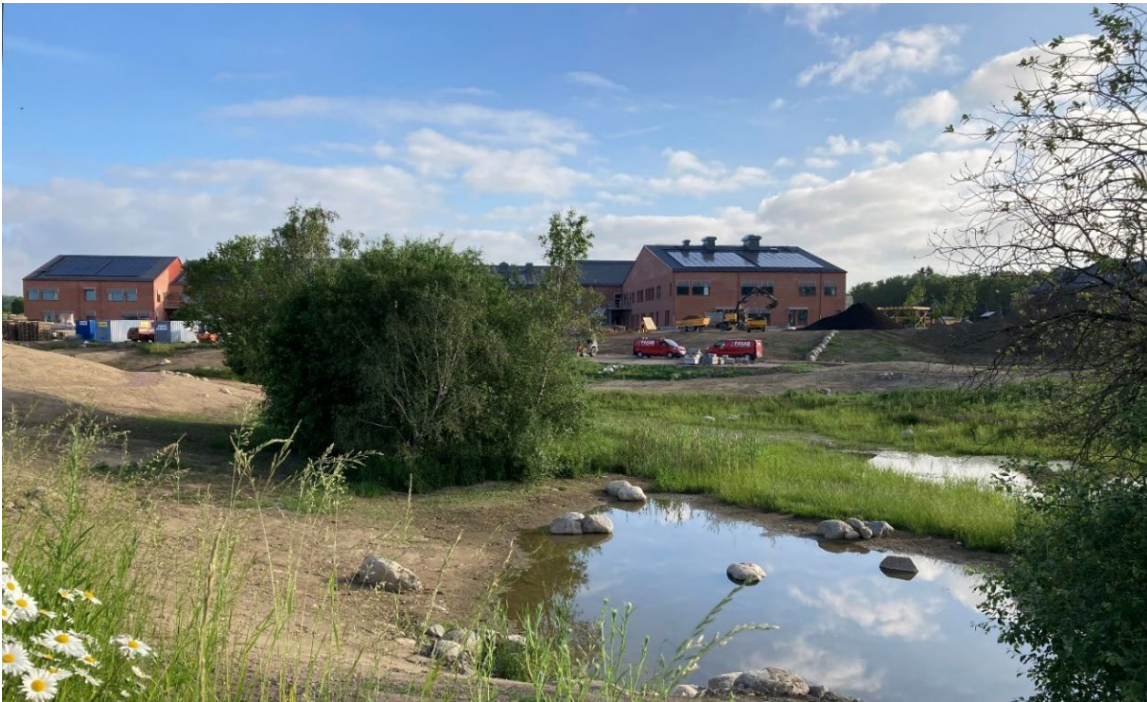
Figur 22. Fotot visar vy över dagvattenanläggning söder om skola och förskola. Dagvattenanläggningar ingår inte i föreliggande detaljplan. Från planområdet leds dagvattnet till de blågröna stråken som redan är anlagda varav dammen på fotot är en del, foto maj 2024.
