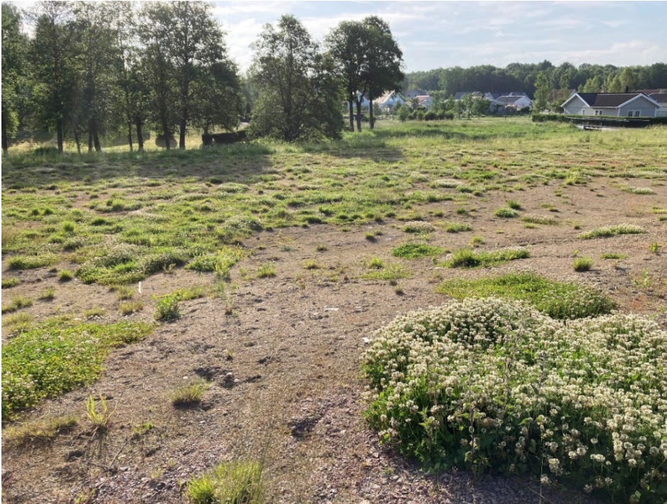
Figur 28, Fotot visar vy över schaktad mark söderut från planområdets östra del med redan planlagd kvartersmark.
