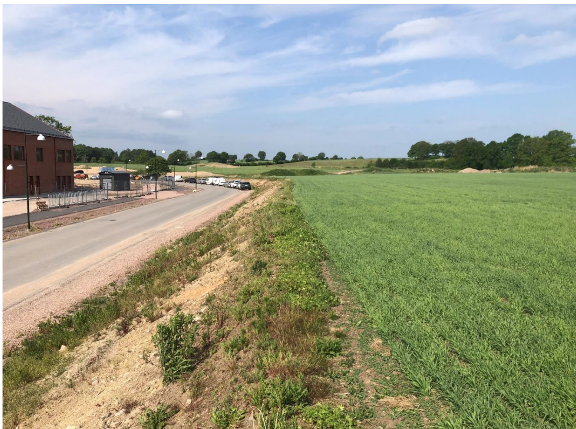
Figur 1. Fotot visar planområdet till höger och den nybyggda skolan (maj 2024) inom stadsdelen Maglehill till vänster. Planområdet är beläget i en kil söder om väg 13, som skymtar mellan åkern och träden. Jordhögarna och bullervallen som håller på att anläggas, ska skydda bostäderna inom planområdet från trafikbuller från väg 13 som västerut leder mot Eslov och österut mot Höör- Hörby.
