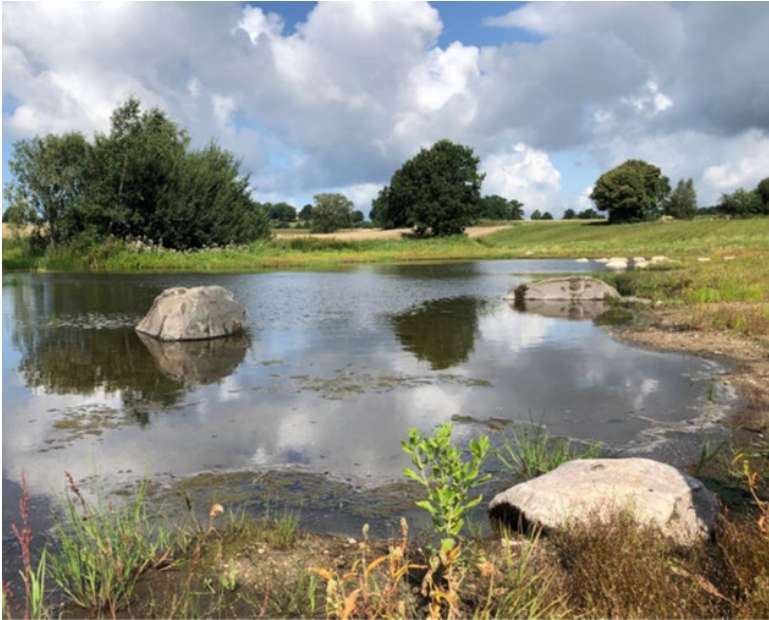
Figur 7. Foto från söder över det västra blågröna stråket med dagvattendamm intill Maglasätevägen inom angränsande detaljplan. Marken har formats med kullar och stenar och vattendraget som tidigare var ett åkerdike har meandrats för att fungera som näringsfällor.
