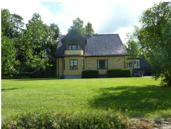
Norra Rörum 8:28 (Tyringevägen 28) Byggår: 1936 Genomgripande förändringar, bl a tilläggsisolering med gult tegel gjort före 1983. Ursprungligen reverterat. K4, M2
