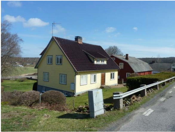
Norra Rörum 10:10 (Hallarödsvägen 4) 1 ½-plans bostadshus klätt med gul, liggande panel. Tegeltak. Takkupa mot söder. Panelklädd magasinbyggnad med valmat eternittak. Var förr spannmålsaffär och vedhandel. Byggår: 1932
