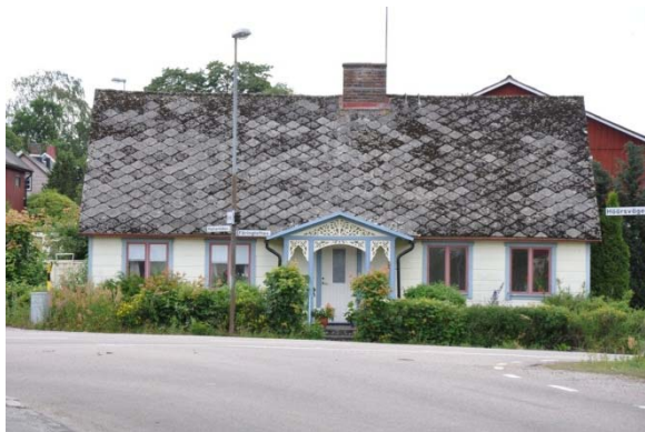
Norra Rörum 10:5 (Hallarödsvägen 2) 1 1/2-plans bostadshus i trä på gråstensgrund, från tidigt 1900-tal. Fasaderna klädda med vita sidiplattor (sedan 1967). Sadeltak med eternit. Veranda med snickarglädje. K2, M2
