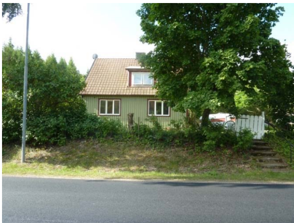
Norra Rörum 7:24 (Höörsvägen 20) Byggår: 1940-tal. 1 ½-plans bostadshus. Förändringar: tak. En relativt välbevarad och tidstypisk egnahemsvilla. K2, M3
