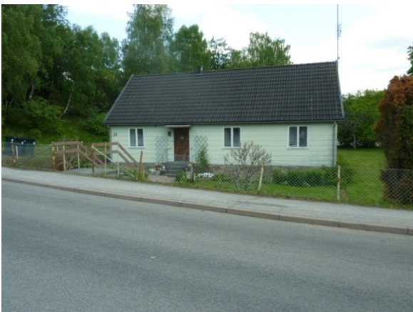
Norra Rörum 8:7 (Tyringevägen 22) 1 ½-plans bostadshus. Byggår: 1896. Förändringar: fasadbeklädnad (eternit), fönster, dörr, tak. K4, M2
