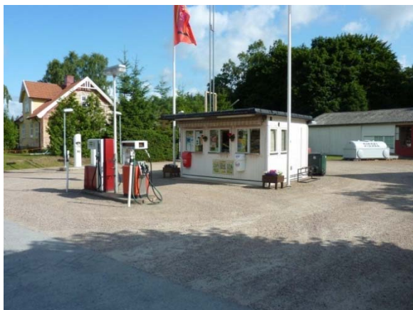
Villan har genomgått stora förändringar men macken och kiosken är välbevarade och typiska representanter för sin tid. I Sverige ökade biltrafiken snabbt under 1950- och 1960-talet och macken och bilverkstaden visar denna utveckling. Bostadshus: K4, M3 Mack och kiosk: K2, M2 Verkstad: K2, M3
