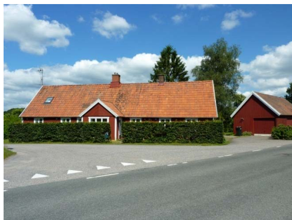
Norra Rörum 8:4 "Elisabetsro" (Tyringevägen 27) Bostadslänga i trä på gråstensgrund från 1800-talets senare hälft. Fasaderna är täckta med röd locklistpanel. Sadeltak täcktt med tegel. I huset fanns tidigare byns poststation. Garage i vinkel.
