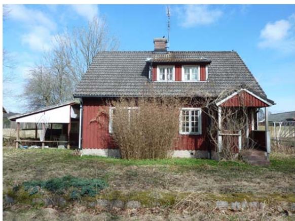
Norra Rörum 8:21 (Blomstergatan 8) Byggår: 1930-tal. Förändringar: tak, uterum. K2, M2
