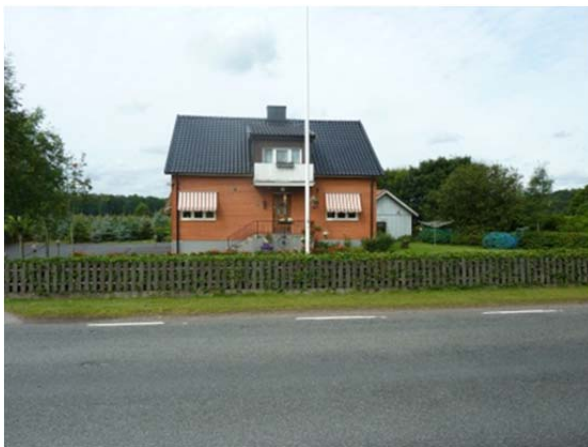
Norra Rörum 2:3 (Tyringevägen 11) Uppfördes som villa 1952. Byggherre: Syskonen Augustsson. Från 1967 banklokal för Färs och Frosta. Sedan 2002 åter bostad. Förändringar; tak, fönster, tilläggsisolering med rött tegel (ursprungligen reverterat) K4, M3
