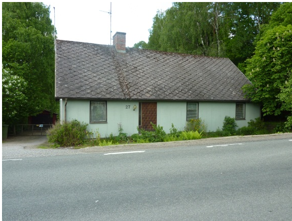
Norra Rörum 8:6 (Tyringevägen 26 A) 1 ½-plans bostadshus, fd missionshus. Byggår: ca 1900. Förändringar; fönster, dörr, fasadbeklädnad (sidiplattor). K3, M2
