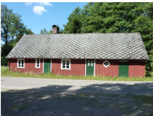
Norra Rörum 8:19 (Hjällarödsvägen 15) Välbevarat fd soldattorp från 1820-30- talet. Exteriören är oförändrad sedan förra inventeringen. Originalfönster. K1, M1
