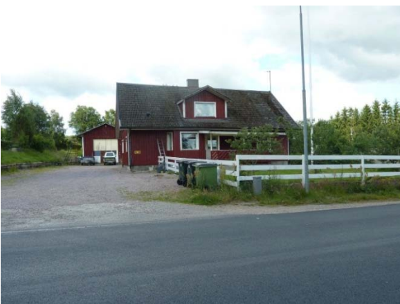
Norra Rörum 7:34 (Höörsvägen 6) Byggår 1930-40-tal? Byggnaden har genomgått genomgripande förändringar, t ex tilläggsisolering, entré, fönster. Övrig bebyggelse
