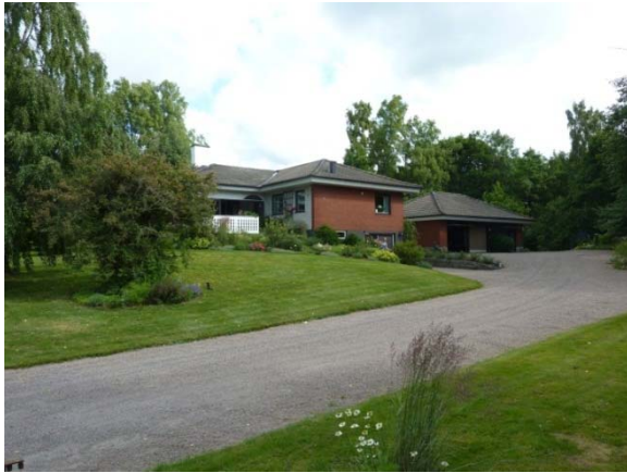
Norra Rörum 7:40 (Höörsvägen 7) Byggår 1970
