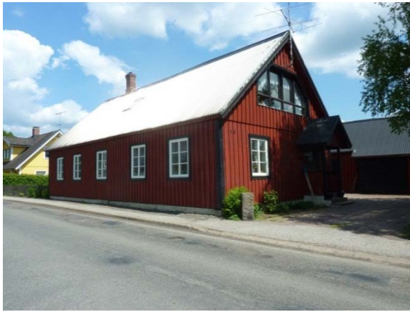
Norra Rörum 8:50 (Sallanders väg 7) Bostadshus i ett plan med inredd vind. Byggår: sent 1800-tal? Fungerade som sjuk- och fattigstuga. Förändringar: tak, fönster, panel K4, M1
