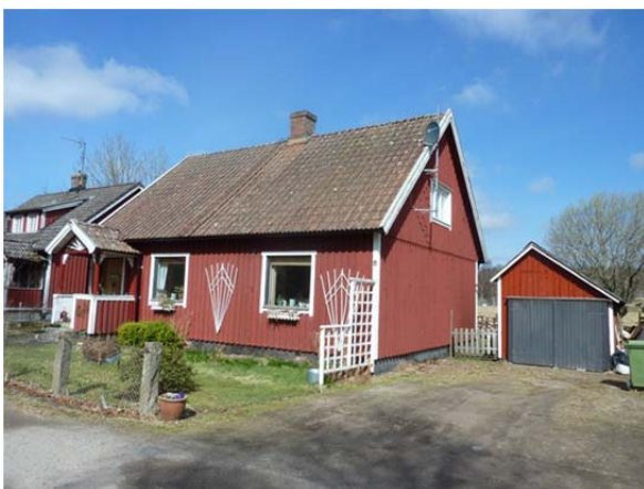
Norra Rörum 8:20 (Blomstergatan 6) Byggår: 1930-tal. Förändringar: tilläggsisolering, fönster, farstukvist. tak. K4, M2
