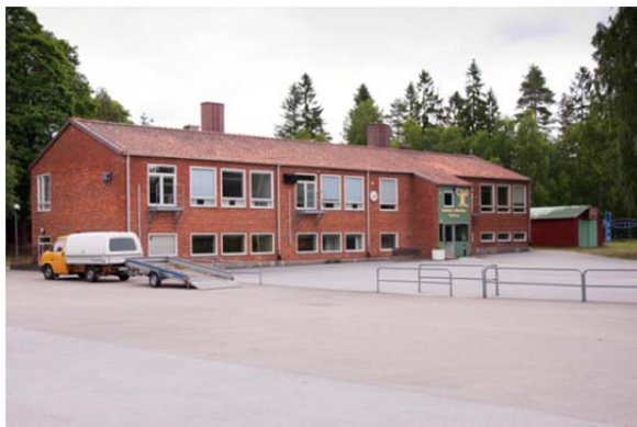
Norra Rörum 8:40 (Tyringevägen 26 A-D) Norra Rörums skola byggdes 1952. På 1980-talet gjordes en tillbyggnad som består av idrottshall och en mindre samlingslokal. En paviljong uppfördes vid samma tillfälle. Skolan är tidstypiskt uppförd i rött tegel med olika fönstertyper.
