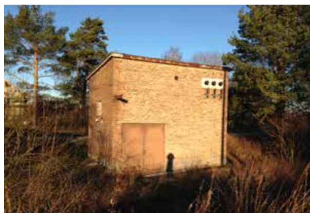
Ställverk uppfört i Gunnarpstegel.
