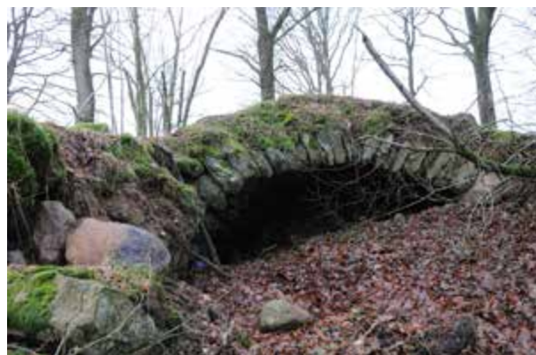
Ruin efter kallmurad stenkonstruktion, troligen tidigare linbastu för torkning av lin. Slättaröd 3:3.
