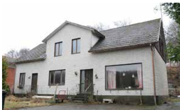
Eken 21 på Landsvägen 70, foto januari 2014. Huset, har genomgått genomgripande förändringar under 1900-talets senare hälft, med bland annat tegling av fasaderna och fönsterupptagningar. Den senare uppförda vinkelbyggnaden (ej synlig på bild) har kvar sina panelade fasader.
