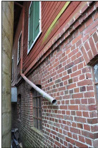
Magasins- och kvarnbyggnad från slutet av 1800-talet. Funktionell bruksarkitektur i tegel och trä. Överst: detalj av gjutjärnsfönster i bottenvåningen. Naturstensgrunden är typisk för Höör. Foto: Staffan Olofsson.
