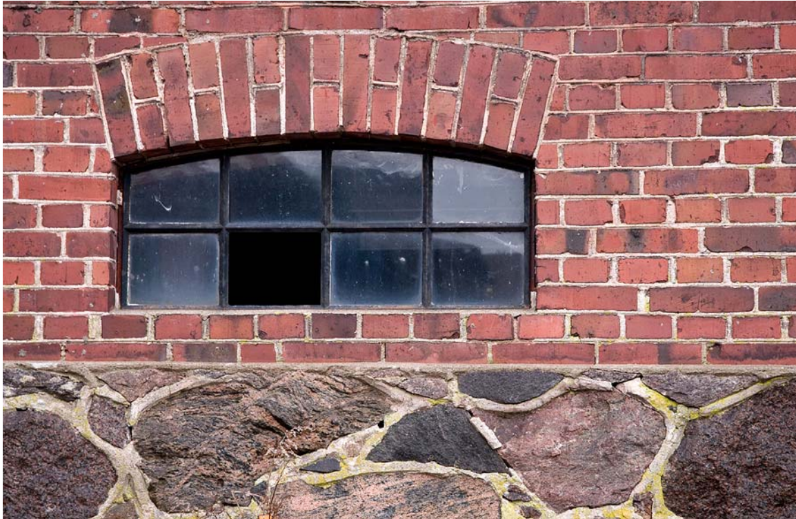
Magasins- och kvarnbyggnaden, detalj av gjutjärnsfönster i bottenvåningen. Foto: Staffan Olofsson.
