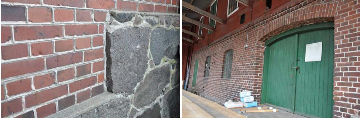
Kvarnens västra fasad. Den höga naturstensgrunden är typisk för Höörs tidiga bebyggelse. Rött lertegel med vackert arbetade åsfogar, gjutjärnfönster och dörrar infogade i stickbågiga murade öppningar.
