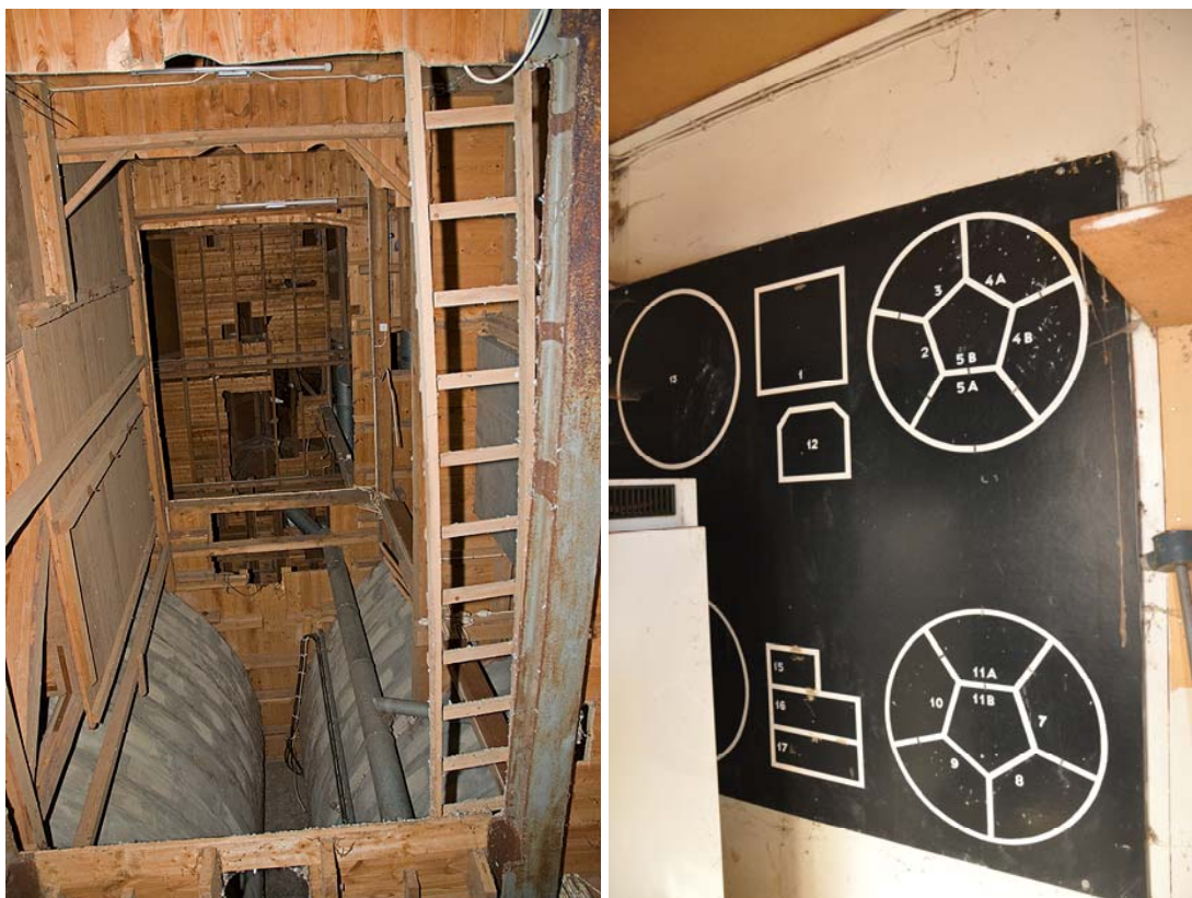
T v: Inuti silon. I centrum fanns tidigare en torkanläggning. T h: manövertavla där man kan se hur silons utrymme är organiserat. De två tornen till höger är skiktade i olika enheter.
