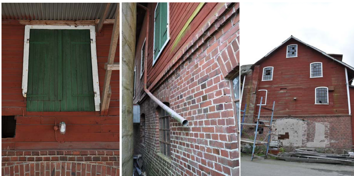
Fr v: Tvådelad slagport, västra fasaden. Mitten: Östra fasaden är sammanbyggd med silon. Notera den teglade gördelgesimsen som skiljer bottenvåning från ovanvåning. Th: Norra gaveln.
