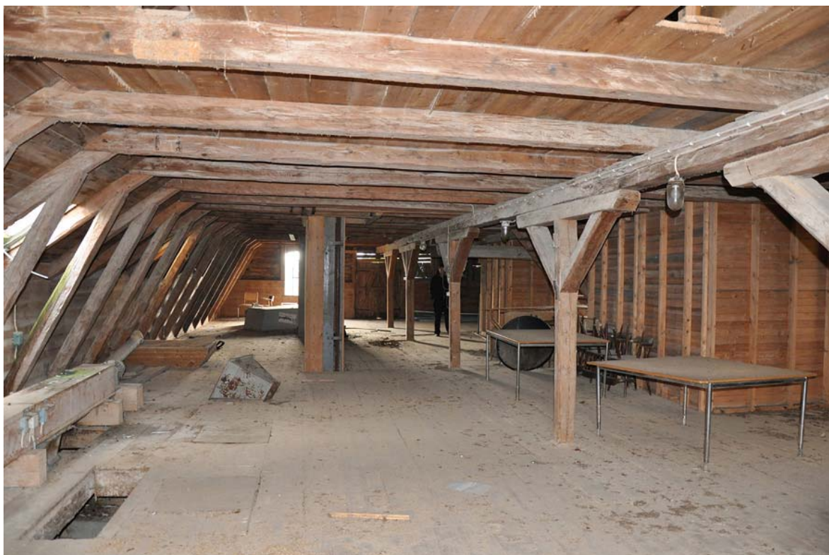
Andra våningsplan från norr. Pelarraden delar in salen i två "skepp". Till vänster i bilden syns den enda kvarvarande matarskruven och till höger syns två spannmålsbehållare. I bildens centrum syns säckhissen.
