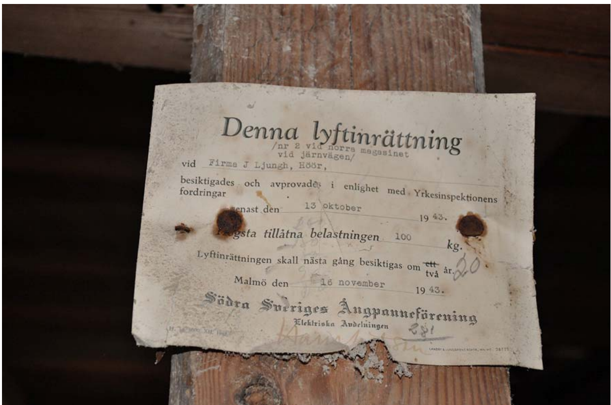
Andra våningsplan uppvisar tydliga spår efter den tidigare spannmålshanteringen. Underst: Etikett fastsatt på pelare: "Denna lyftinrättning /nr 2 vid norra magasinet vid järnvägen/ vid Firma J Ljungh, Höör, besiktigades och approvades i enlighet med Yrkesinspektionens fordringar senast den 13 oktober 1943. Högsta tillåtna belastningen 100 kg ... Malmö den 16 november 1943. Södra Sveriges Ångpanneförening Elektriska Avdelningen."
