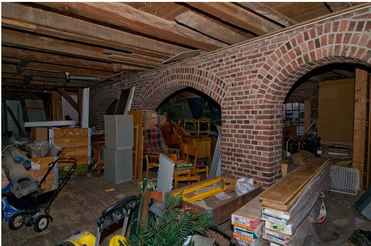
Magasins- och kvarnbyggnaden då och nu. Bottenvåningen. Murade stödvälv om 1,5 stens bredd bär upp ovanvåningen. Konstruktionen med längsgående stöd under långa golvbjälkar är tidigmedeltida. Byggnaden från sent 1800-tal har haft flera användningsområden: magasin, lantmannaaffär, madrassfabrik och kvarn. Senast användes byggnaden som kvarn. Överst: Från madrassstillverkningens dagar finns ett foto bevarat, från åren strax före 1920-talet, tidigast 1915. Av bilden att döma rörde det sig om en hantverksmässig tillverkning av madrasser. Ur Knut Jönssons bildsamling, Höörs kommun. Underst: magasinets bottenvåning är i dag belamrad med föremål. Foto: Staffan Olofsson.
