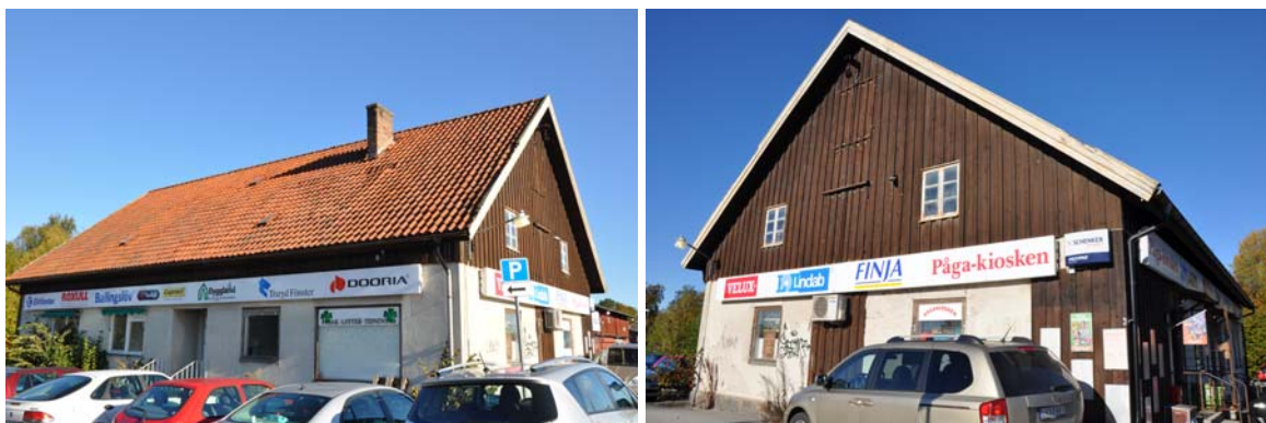
T v: Pågakiosken från söder, fasad utmed Åkersbergsgatan. T h: Södra gaveln som vetter mot järnvägsspåret. Observera vinschanordningen i träpanelen.
