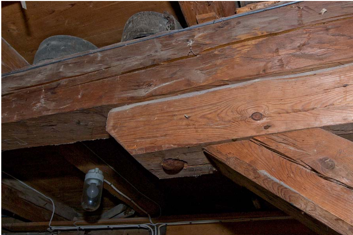
Bärande träkonstruktion i kvarnbyggnadens övre våningsplan. Äldre industriarmatur med vit lamphållare i bakelit och konisk kupa i klarglas. Foto: Staffan Olofsson.
