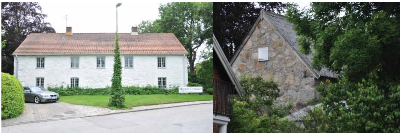
Lejonet 13, Lantmannagatan. Byggnaderna ingick tidigare i gårdskomplexet Åkersberg. Foto: 2012.
