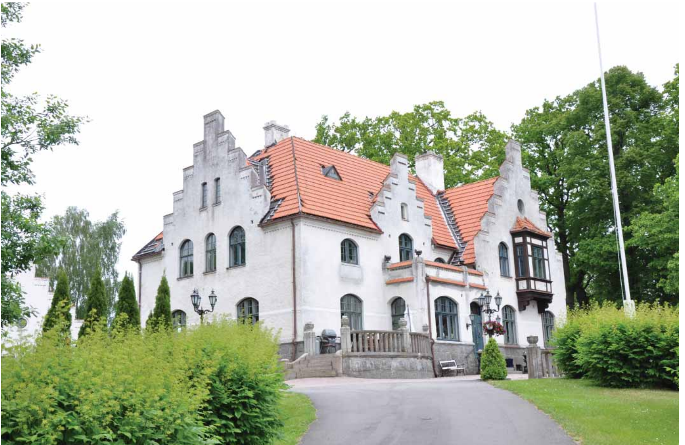
Fotona tagna under pågående takarbeten sommaren 2011.
