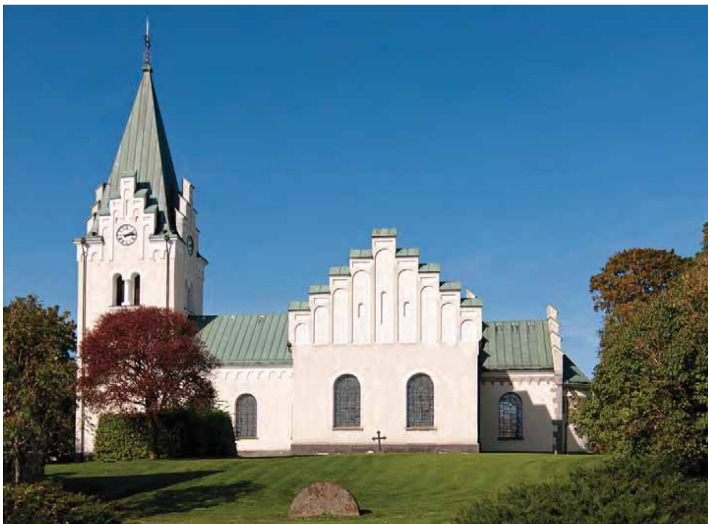
Hörs kyrka är uppförd av Mårten Stenmästare under senare hälften av 1100-talet. Liksom Lunds domkyrka är den byggd med sandsten från Hörs stenskog. 1800-talets omfattande restaureringar och ombyggnationer har gett kyrkan det utseende den har i dag. Foto: Staffan Olofsson.
