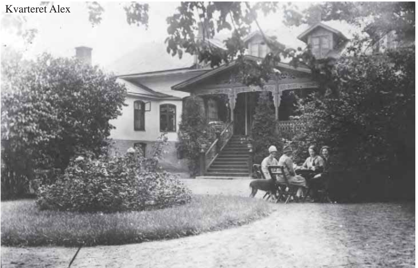
Anna Månssons conditori. Alex 2 vid Gamla Torg, sannolikt uppfört under 1880-talet. D höga sockeln är sannolikt slammad. Färgsättningen är kontrastrik med mörka fönstersnickerier, möjligen gröna. Till verandans snickerier har två färger använts, möjligen en ljusare och en mörkare nyans av samma kulör. Foto ur Knut Jönssons bildarkiv.
