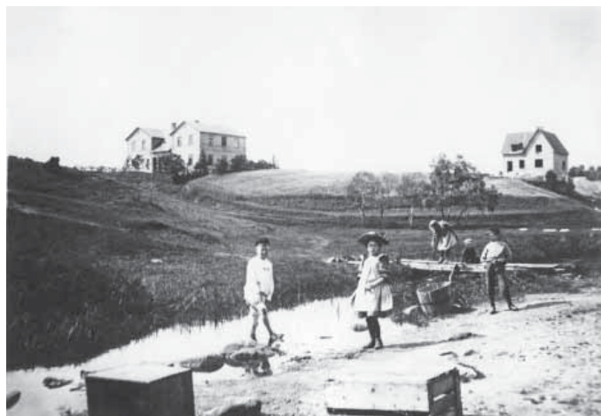
Spinneridammen. Elementarskolan t v i bilden. Huset t h är Villa Kullebo från 1907 (rivet i dag). Foto från 1908 ur Knut Jönssons bildsamling.
