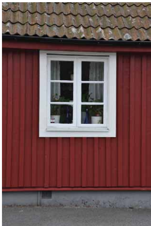
Röd locklistpanel, lertegeltak och spröjsat tvåluftsfönster. Gatehus på Grönalundsvägen.
