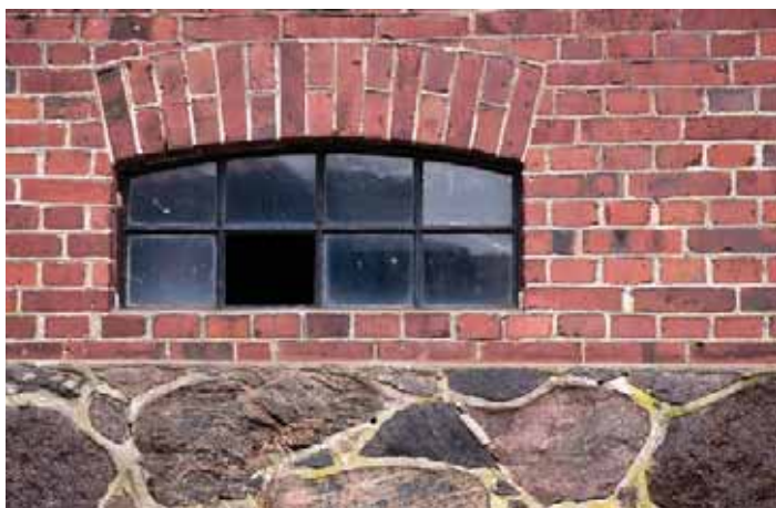
Kvarnbyggnad från sent 1800-tal, Bävern 10. Den höga naturstensgrunden är typisk för Höörs tidiga bebyggelse. Rött lertegl med vackert arbetade åsfogar, gjutjärnsfönster infogade i stickbågiga murade öppningar. Foto: Staffan Olofsson, 2012
