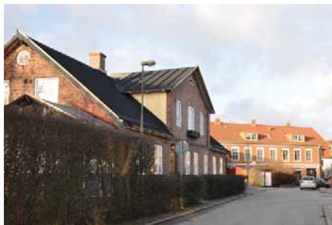
Handelsgatan idag. Närmast t v syns Södra Ljungen 1 under pågående omtäckning av taket. Bakom häcken döljer sig glasverandan. Rakt fram syns Norra Ljungen 2.
