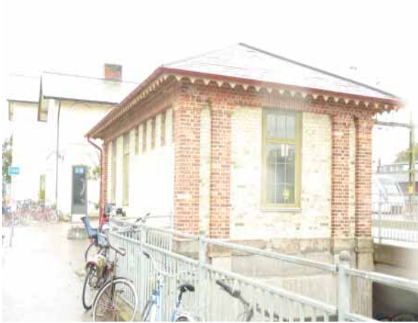
Avträdeshuset från 1885 räddades till det yttre 1995 då det fick en ny funktion som trapphus.
