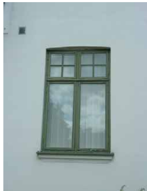
Originalfönster med originalbeslag på Fyrkanten 3 från 1905.
