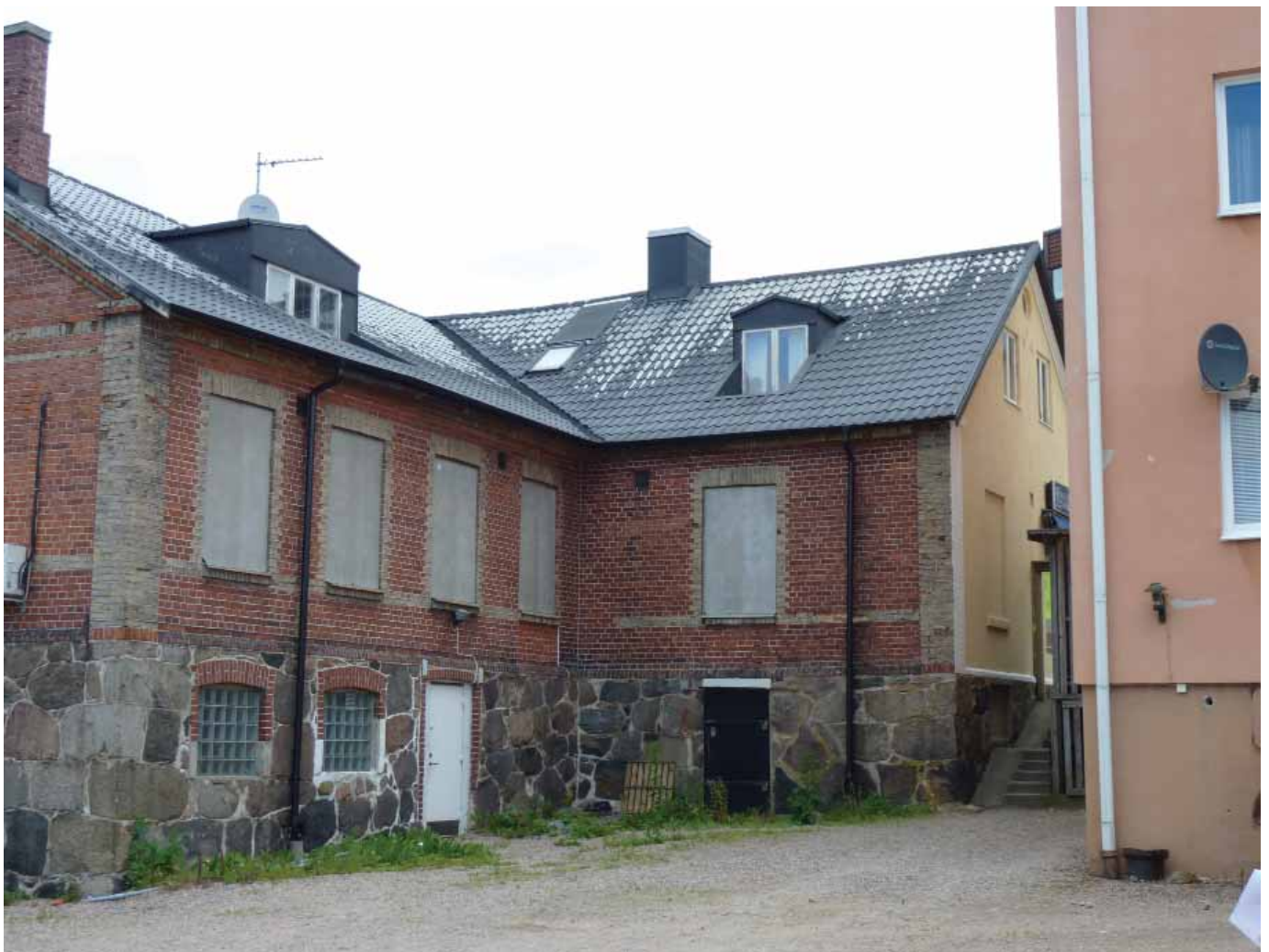
Hus i tegel är ett särdrag för skånska stationssamhällen. I Höör har många hus fått sina tegelfasader överputsade på senare år. Baksidan på Lyran 3 visar de ursprungliga tegelfasaderna och en hög naturstensgrund vilket är ett lokalt särdrag för Höör.
