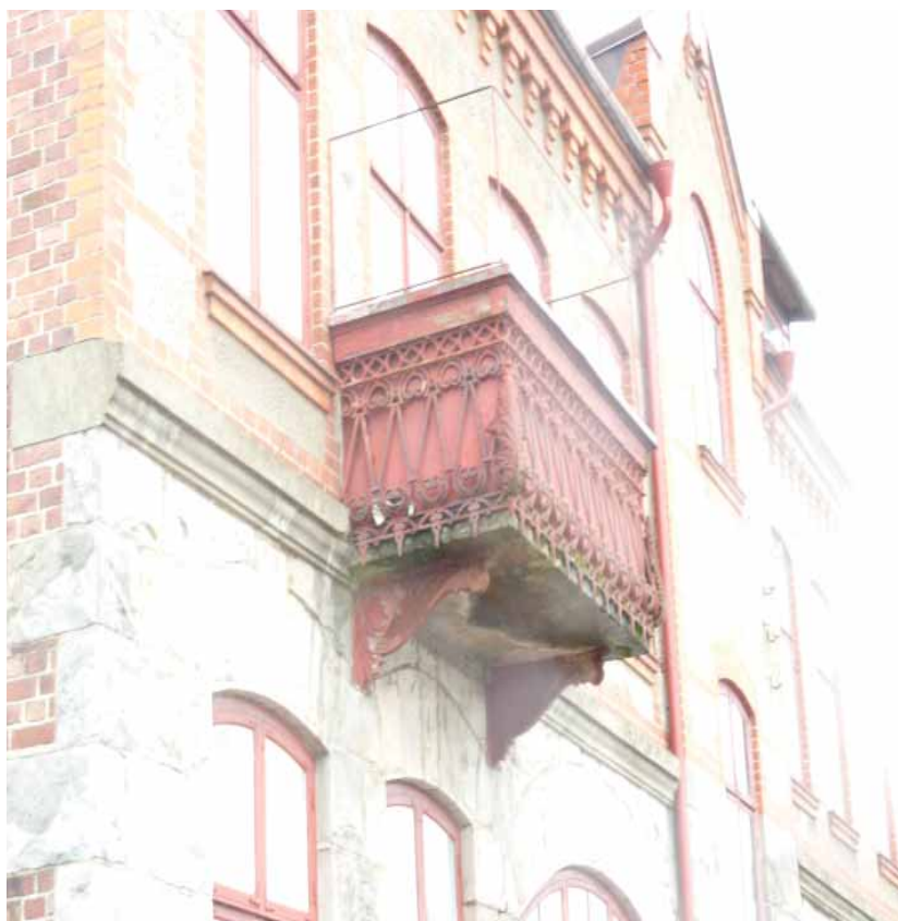
Tidstypiskt dekorerat tegelhus. Originalfönster och smidesbalkong mot gatan. Karlstorp 8 är ett bra exempel på sekelskiftets tegel- och stenarkitektur.
