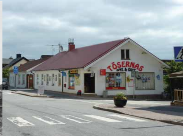
Munken 1 är ett av stationssamhällets äldsta hus och uppfördes 1860 av Bosjökloster gods.
