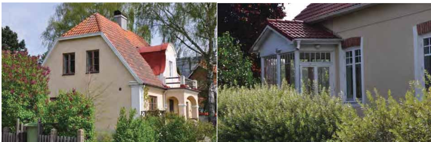
T v: Storken 27 på Flygarevägen 3, från 1923. T h: Svanen 1 på Stenskogsvägen 27, uppfört samma år.
