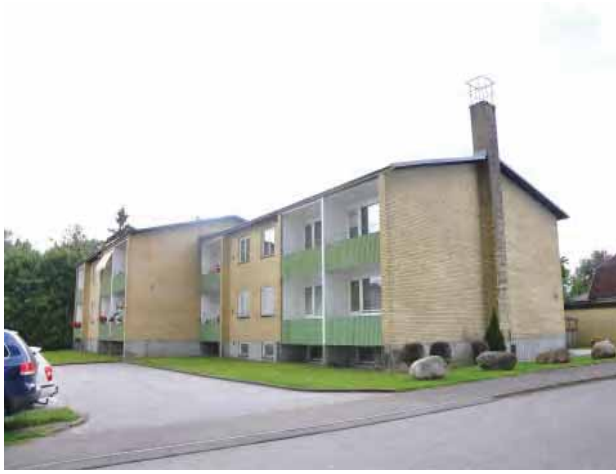
Laxen 6 (Munkarpsvägen 13 a-b) Flerfamiljshus i två våningar Byggår: Uppgifter saknas. 1960-tal?
