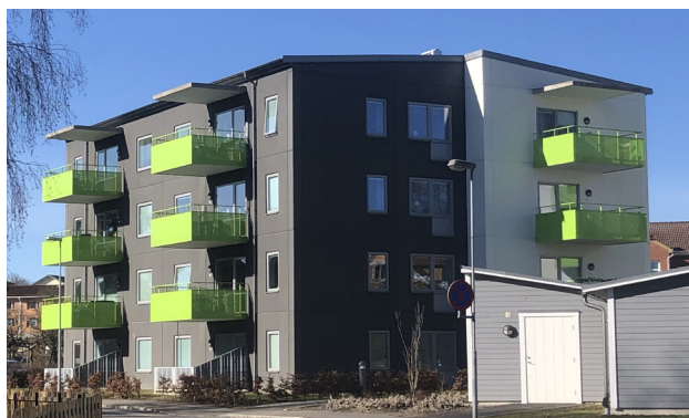
Luftigt flerbostadshus i centrala Höör
