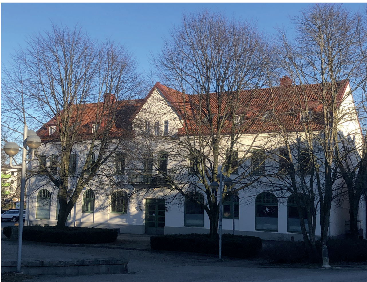
Höörs fastigheter har ungdomslägenheter i takvåningen vid Lilla torg.
