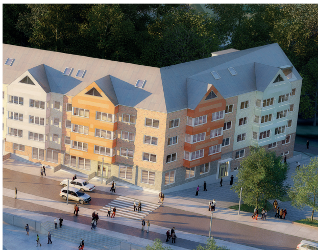
Kvartersstad vid Västra stationsområdet i Höör
