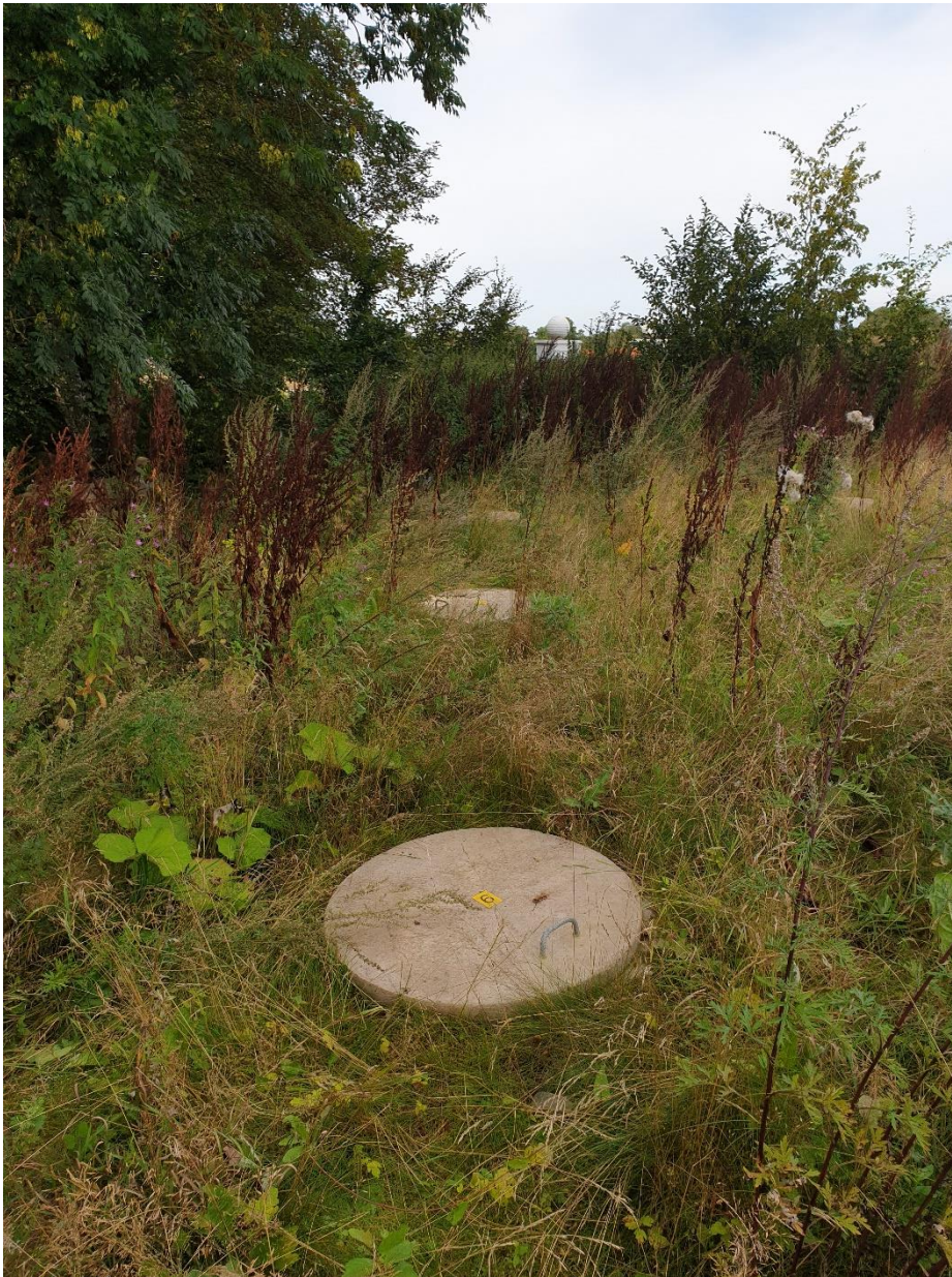
Bild 10. Foto taget av Tyréns under platsbesök 20190823, betongbrunnar i något upphöjd mark med låg vegetation.
