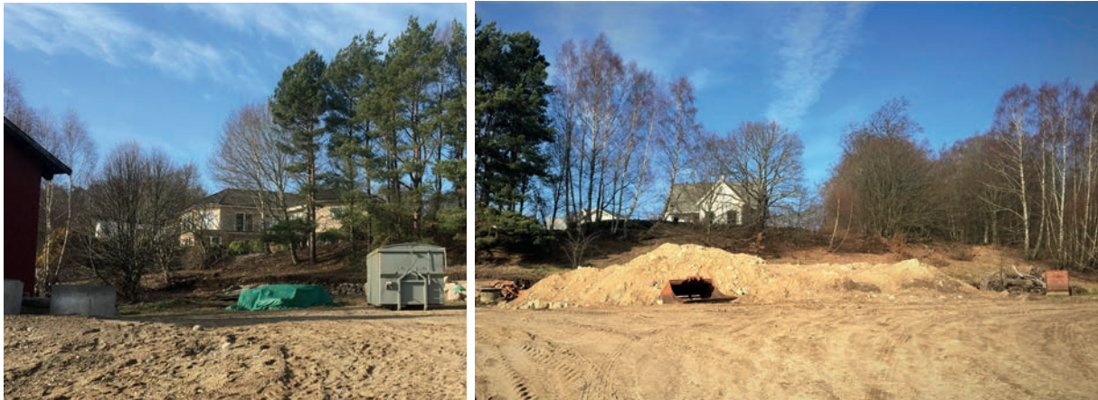
Figur 4, Foto mot nordväst. Ladan i vänstra kanten ska rivas. 5, Foto mot vall i norr med avbanad mark framför.
