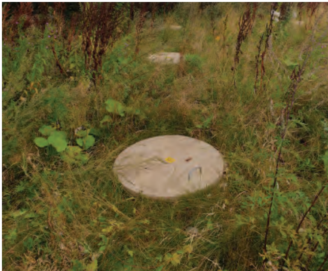
Figur 7. Befintlig spillvattenanläggning. Betongbrunnar i något upphöjd mark, bild Tyréns vid platsbesök 2019-08-23
