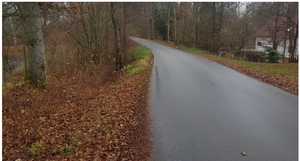
Figur 15. Vägsträckan vid dammen.
