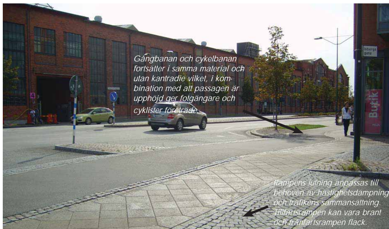
En väl utformad gång- och cykelbana upphöjd över körbanan (exempel från Malmö).
