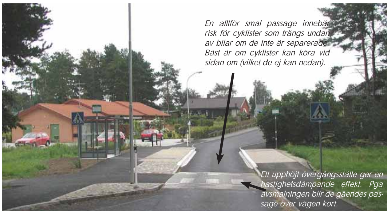
En väl utformad avsmalning av körbanan (timglashållplats) i samband med ett upphöjt övergångsställe (exempel från Kristianstad).
