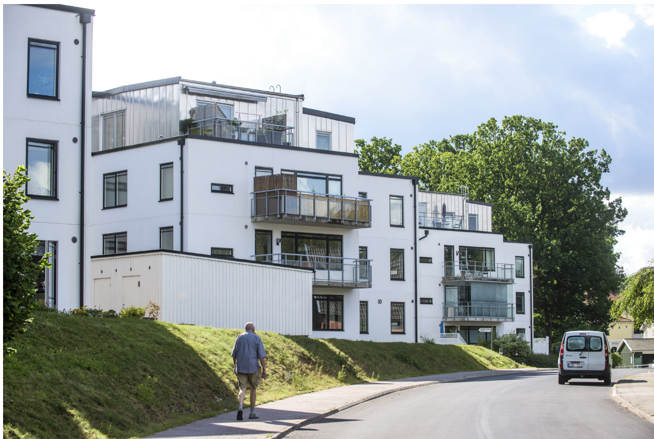
Figur 11. Ekeliden, bostadsrättsförening i centrala Höör.
