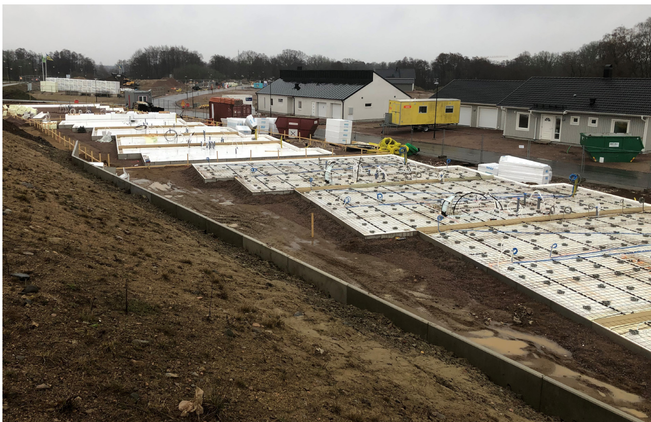
Figur 6. Nybyggnation av flerbostadshus i västra Höör
