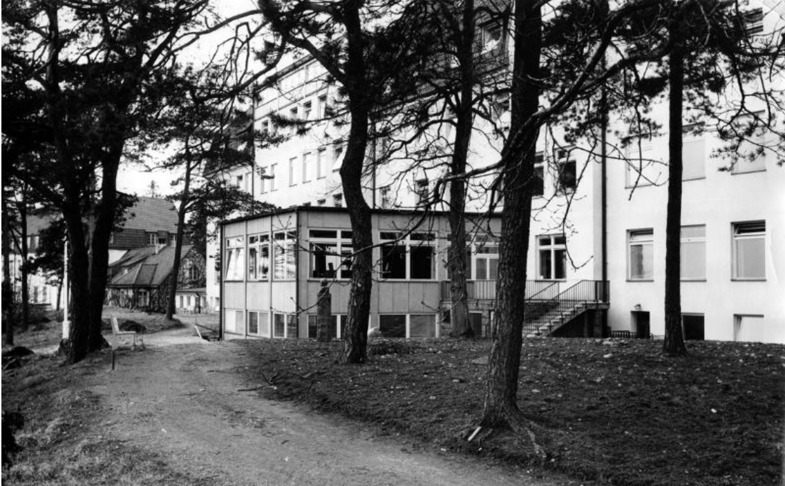
Fotografi, sannolikt taget strax efter 1960-talets ombyggnad då den pampiga huvudentrén ersattes med en tillbyggnad för en samlingsal. En rest av huvudentréns svängda terrass finns fortfarande kvar på var sida om samlingsalen. (Region Skånes medicinhistoriska samlingar, www.kringla.nu )
