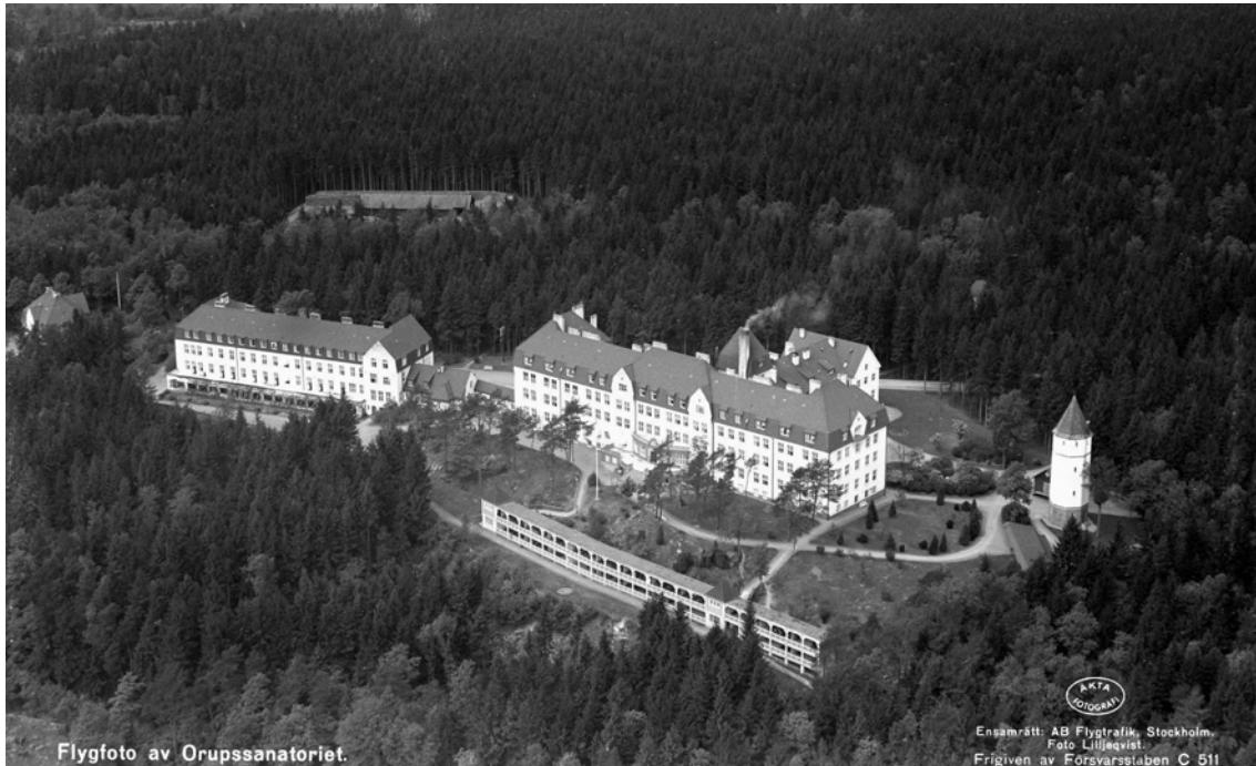
Flygfotografi taget 1935. Notera huvudentrén och ligghallarna nedanför huvudbyggnaden. En stor skorsten med rök visar att huvudbyggnaden har pannrum i källaren. Separat byggnad med panncentral uppfördes 1938. Köks- och administrationsflygeln är här nyligen tillbyggd/förlängd mot norr. Ingår i bildsamling inköpt till Kulturhistoriska museet i Lund år 2000. ( www.carl.kulturen.com )
