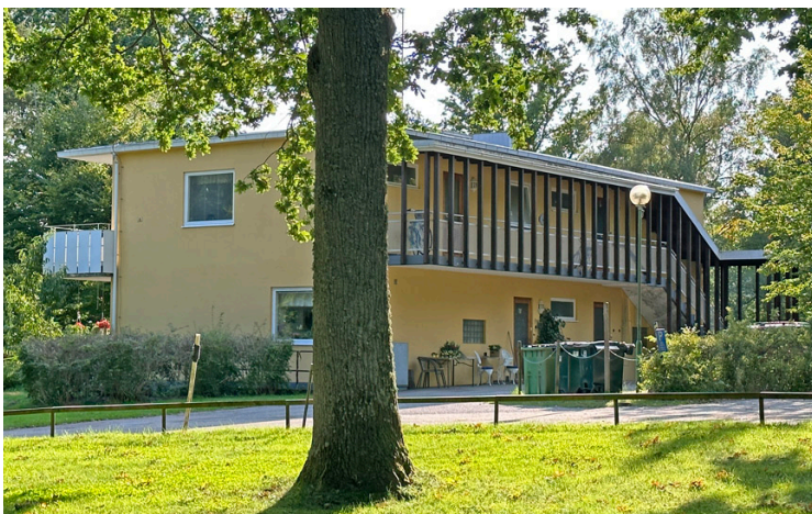
Vy från nordöst. Loftgång och trappa längs norra fasaden.
