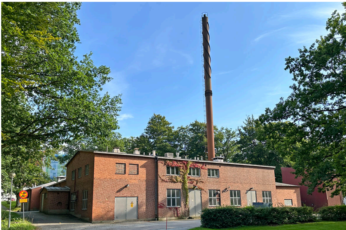
Panncentralen från nordöst. Den mellersta delen är välbevarad från 1930-talet. Den vänstra delen förhöjdes 1960, vilket syns tydligt på tegelfasaden, och byggdes till mot söder. Till höger skymtar nytt, fristående bränslelager med plåtfasad.
