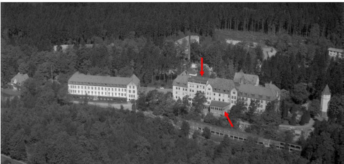
Flygfotografi taget 1959, mitt under den stora ombyggnaden av huvudbyggnaden då fasadpartier höjdes och nya ligghallar uppfördes på taket/vinden. Här har förhöjningen till vänster om mittpartiet utförts (pil) medan förhöjningen till höger om mittpartiet ännu inte genomförts. Samtliga småspröjsade originalfönster ersattes under arbetena med perspektivfönster. Här har byggnadsarbetena kommit halvvägs, den vänstra delen av huvudbyggnaden har nya perspektivfönster medan den högra delen ännu har småspröjsade fönster kvar. Den pampiga huvudentrén mot söder är borttagen och ersatt med en utkragande samlingsal (pil). Skogen är fortfarande tätt inpå byggnaderna. Ingår i bildsamling inköpt till Kulturhistoriska museet i Lund år 2000. ( www.carl.kulturen.com )
