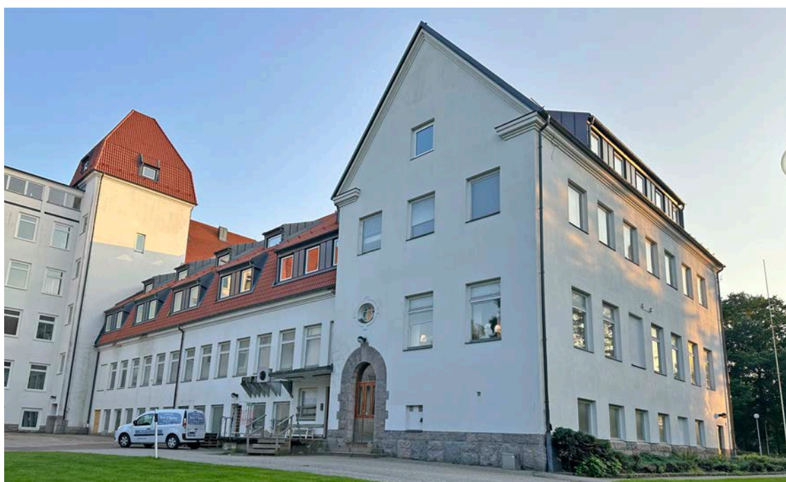
Köks- och administrationsflygelns östra fasad. Foto efter pågående takarbeten.
