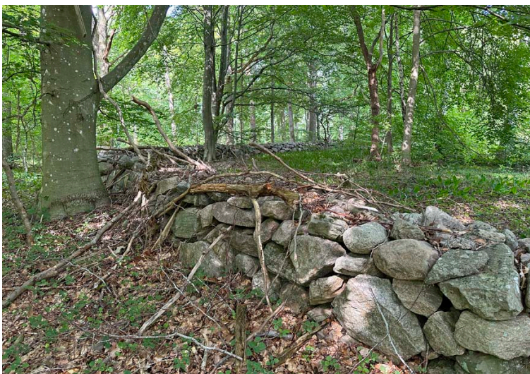
Muren runt den stora köksträdgården för överläkaren och intendenten (sysslomannen) finns bevarad i sin helhet i skogen söder om bostadsbyggnaderna.
