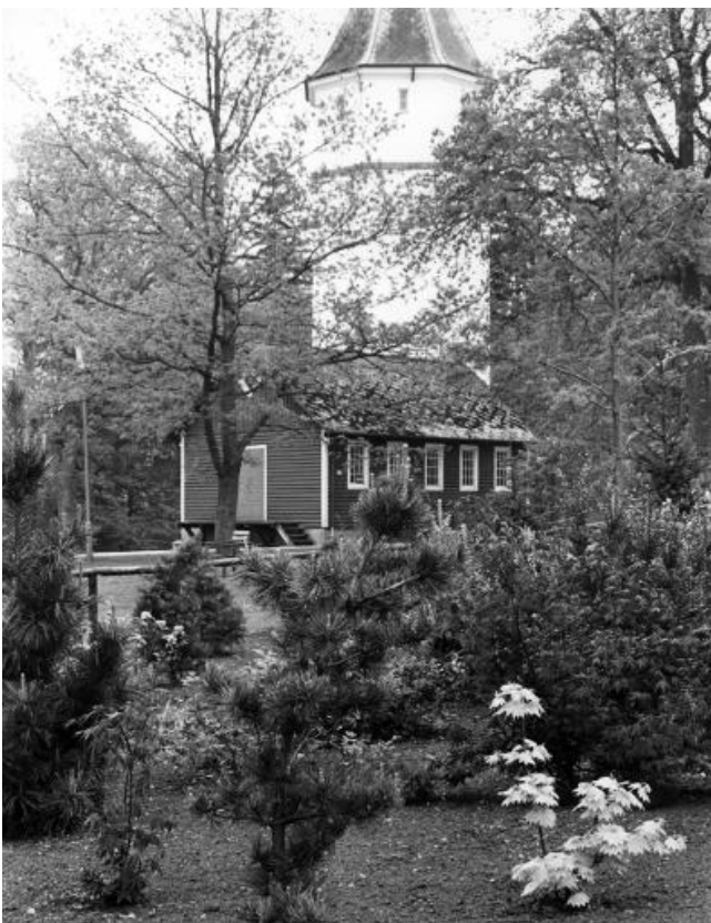
Fotografi, eventuellt från 1960-talet. Vattentornet och luftningshuset. (Sydsvenska medicinhistoriska sällskapet, www.kringla.nu )
