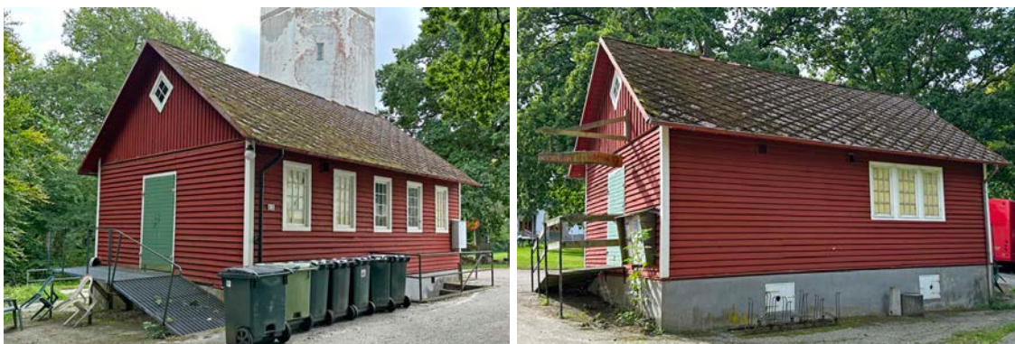
Vattentornet sett från väster respektive sydöst. Nordväst om vattentornet finns luftningshuset. Båda har tak täckta av eternitplattor. Nedan luftningshuset sett från nordväst respektive sydöst.
