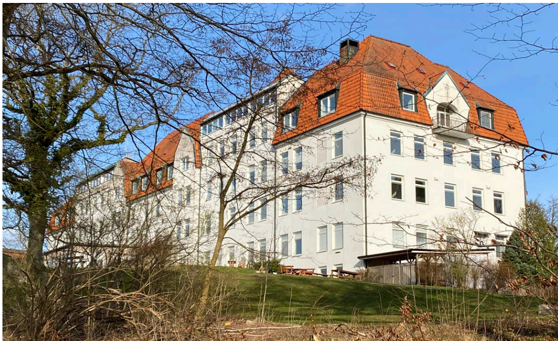
Huvudbyggnaden sedd från sydöst, fotografi taget före de pågående takarbetena. Byggställningar döljer nu delar av fasaderna.
