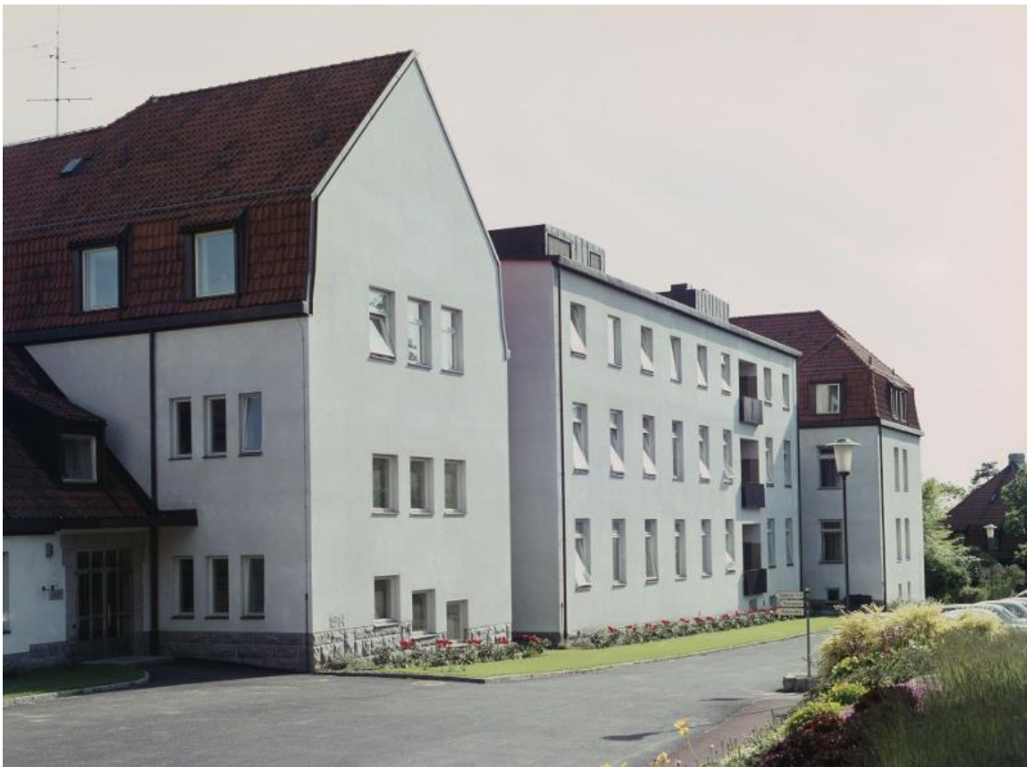
Kolorerat fotografi av paviljongen från nordöst 1967, dvs precis efter dess stora om- och tillbyggnad. Mellan gavelflyglarna hade uppförts en tillbyggnad som breddade huset, dvs flyttade ut fasaden mot norr samt höjde fasaden en våning. På den nya flacka takytan tillkom två kopparplåtsklädda boxar, ventilationsrum. Ingår i bildsamling inköpt till Kulturhistoriska museet i Lund år 2000. ( www.carl.kulturen.com )
