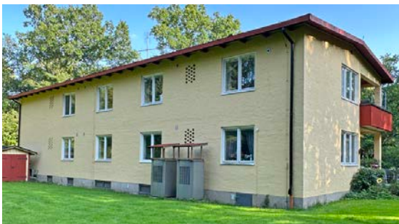
Bostadshusets baksida har eleganta raster/hål-mönster i den murade, putsade fasaden. Trist placerade värmepumpar och förråd vid fasaden.
