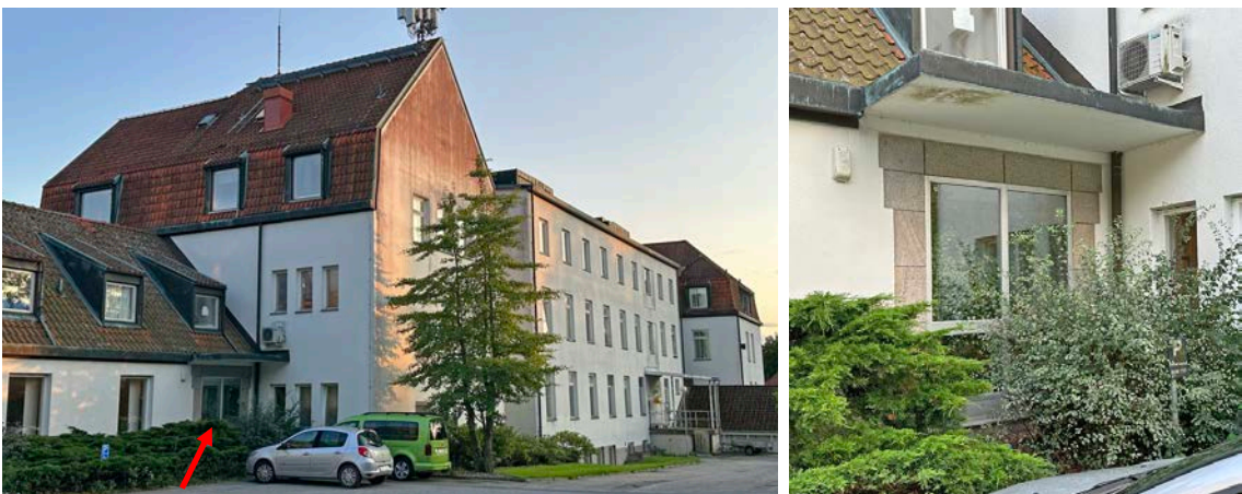
Paviljongen från nordöst. Pilen visar ett fönster som tidigare var en pampig portal i en frontespis. Jämför äldre foto på sidan 56.
