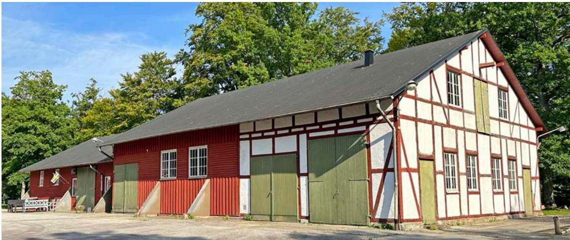
Kol-ladan sedd från sydväst. Byggnaden har ursprungliga fönster.
