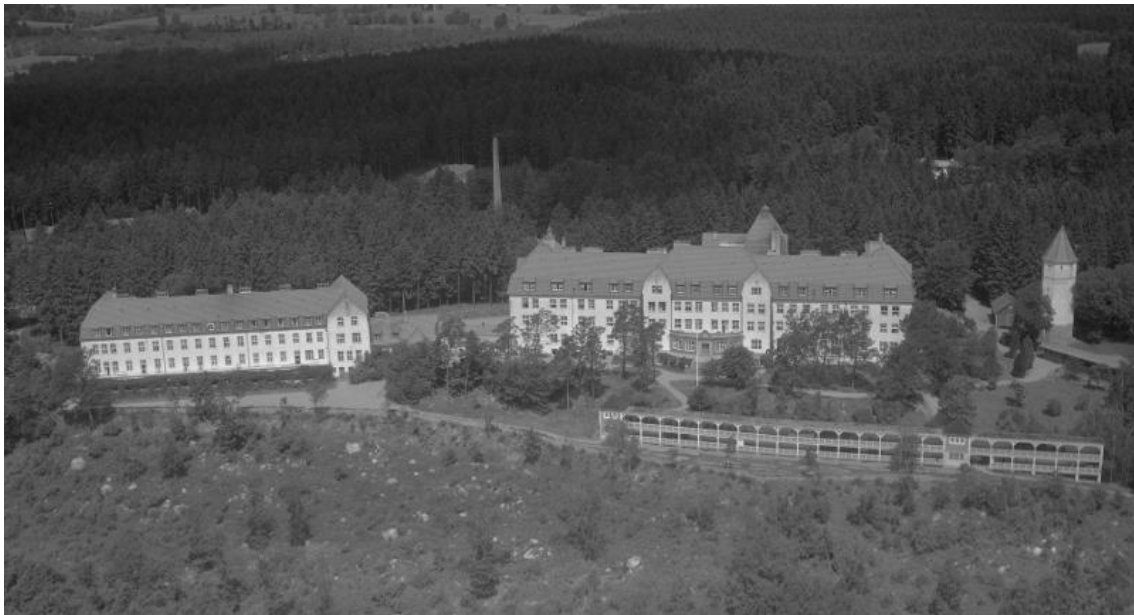
Flygfotografi, troligen taget 1939. Separat byggnad med panncentral och hög skorsten av tegel uppfördes 1938. Ingår i bildsamling inköpt till Kulturhistoriska museet i Lund år 2000. (www.carl.kulturen.com)
