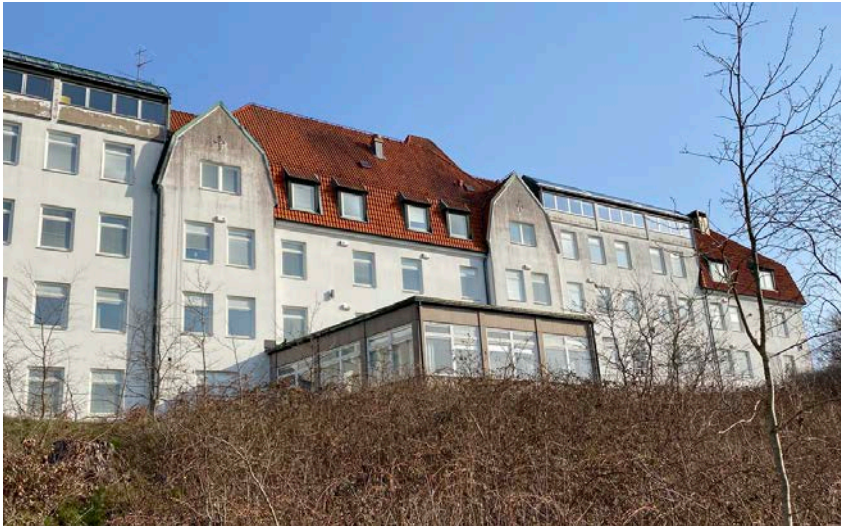
Mittpartiet på huvudbyggnadens södra fasad. Utbyggnad/samlingshall från 1960 i bottenvåningen, där den ursprungliga huvudentrén tidigare fanns. Fotografiet taget före de pågående takarbetena, eftersom byggställningar nu döljer delar av fasaderna.
