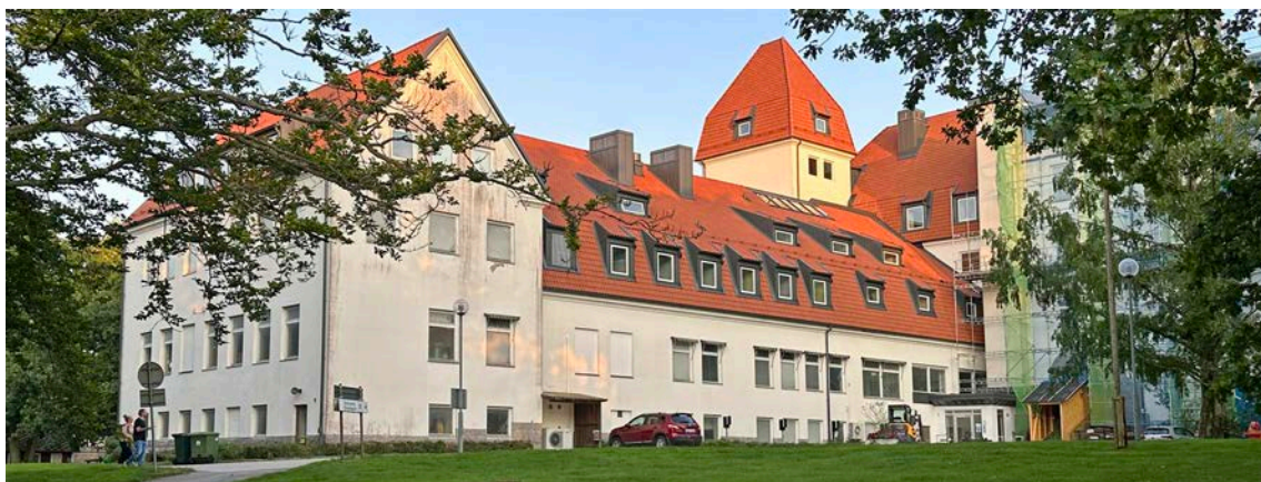
Köks- och administrationsflygelns västra fasad. Foto efter pågående takarbeten.
