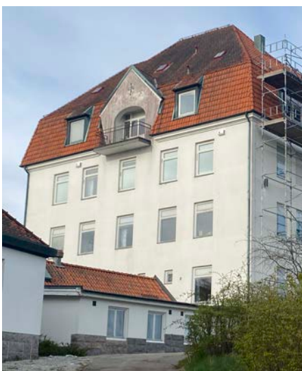
Detalj av huvudbyggnadens västra gavel, foto taget före pågående takarbeten.
