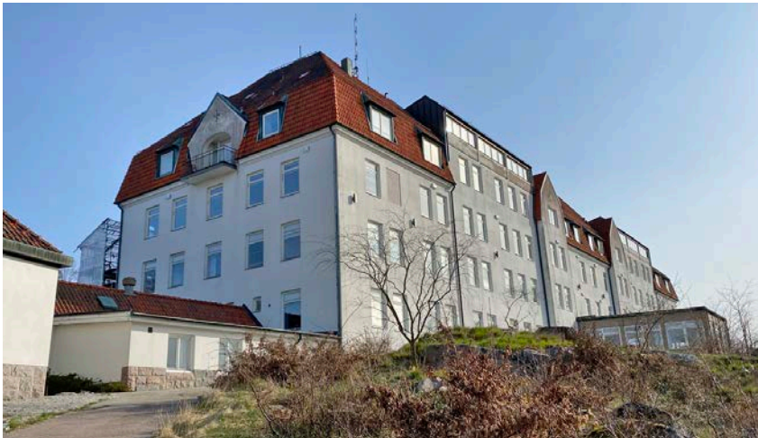
Huvudbyggnaden sedd från sydväst. Fotografiet taget före de pågående takarbetena, eftersom byggställningar nu döljer stora delar av fasaderna.
