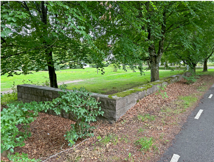
Kvarvarande kvaderhuggen rusticerad stenmur/sockel av granit till sanatoriets portvaktstuga som sannolikt revs på 1960-talet. Den hitre delen av muren omgärdade portvaktens gård och den bortre delen utgjorde del av byggnadens sockel.
