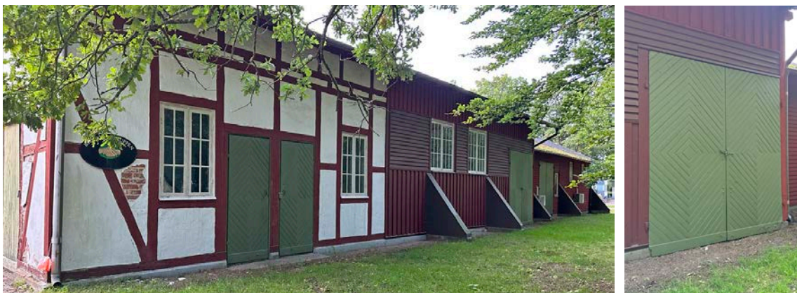
Kol-ladans långsida som vetter mot sydöst. Här finns tre ursprungliga dörrar/portar med pärlspont i rombiskt mönster.
