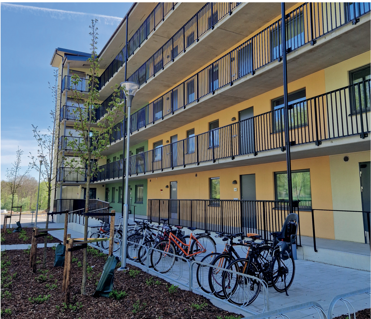
Flerbostadshus på Fogdaröd.. Nybyggnation är en avgörande faktor för utvecklandet av bostadsbeståndet i Hörs kommun.
